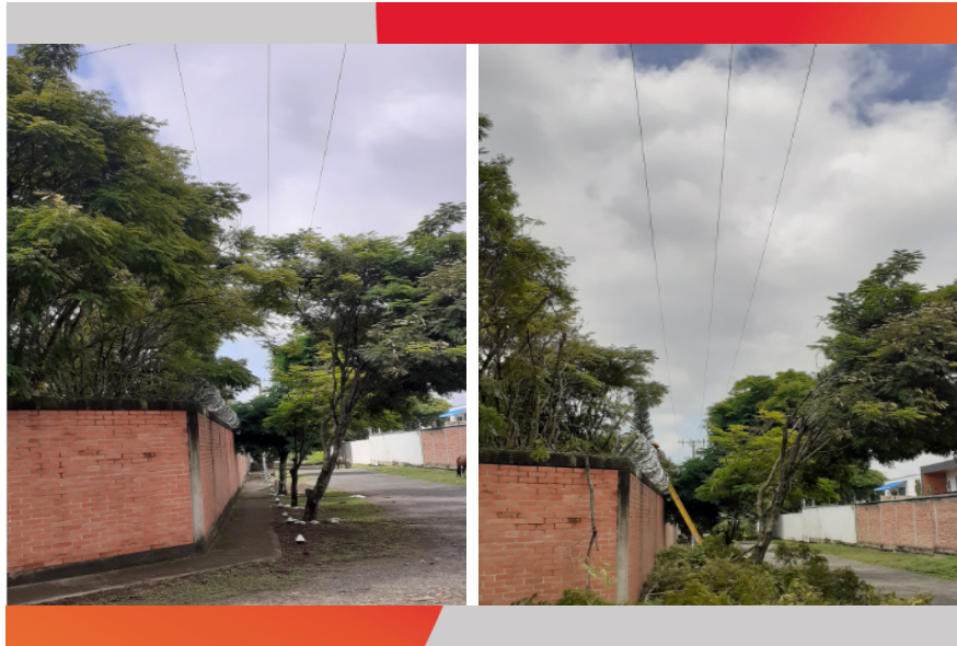
Figura 34. Poda árboles alrededor de redes distribución de energía eléctrica.
