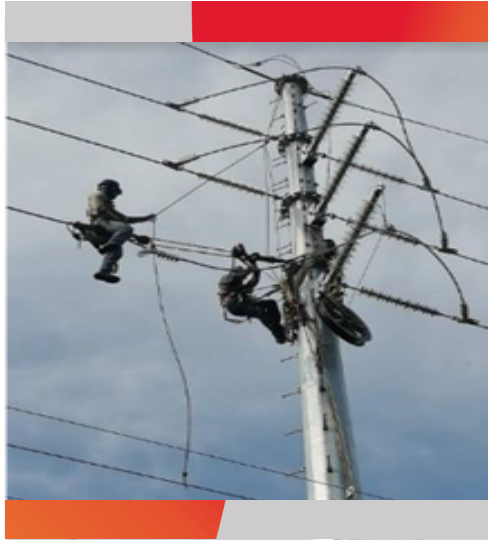
Proceso de construcción de puentes en estructura de retención
